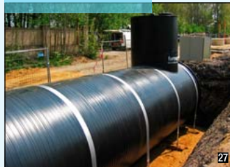
Fasce in acciaio inox per contrastare le spinte di galleggiamento
