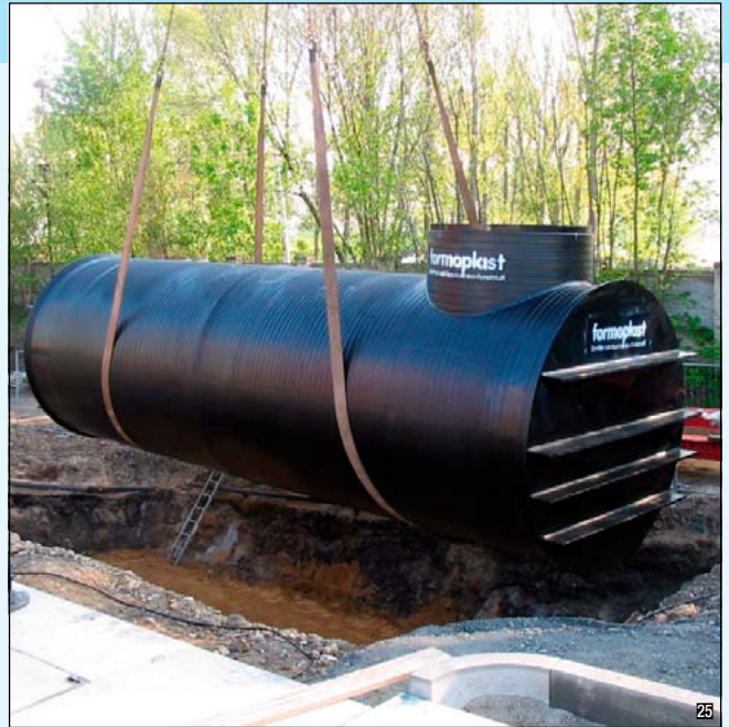
Per un corretto interramento prevedere un perimetro intorno al serbatoio di 500 mm riempito di sabbia
